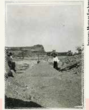
Trabajos de extracción de arenas en El Sotillo (1918). En el centro de la imagen, un obrero ante la montaña de arena resultante del cribado de la tierra. Al fondo aparecen los cortes de tierra del arenero y, tras ellos a la derecha, las naves de los mataderos.
